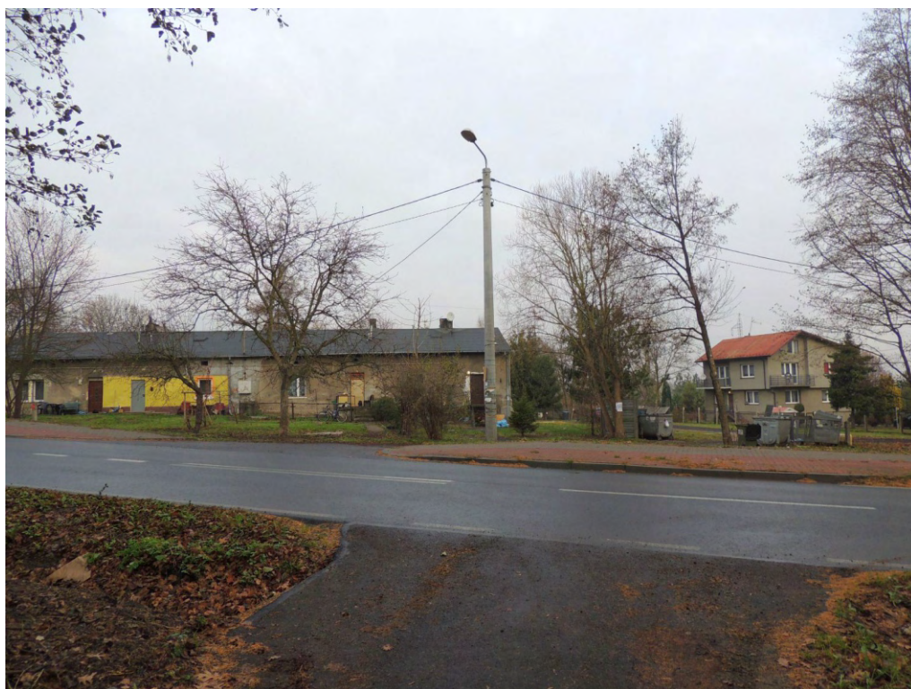
Fot. 1 Teren 1 - ul. Leśna widok na zabudowę, budynek mieszkalny z dawnego folwarku (listopad 2018 r.)
